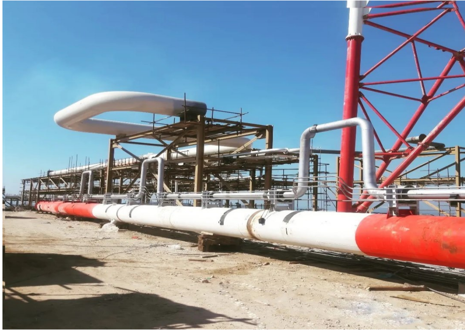
ساخت و نصب فلر پالایشگاه میعانات گازی آدیش جنوبی
