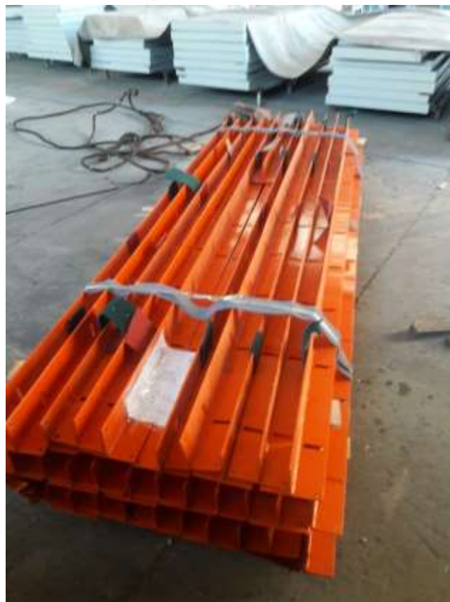
ساخت اسکلت فلزی پروژه جرثقیل های دروازه این بندر شهید رجایی
