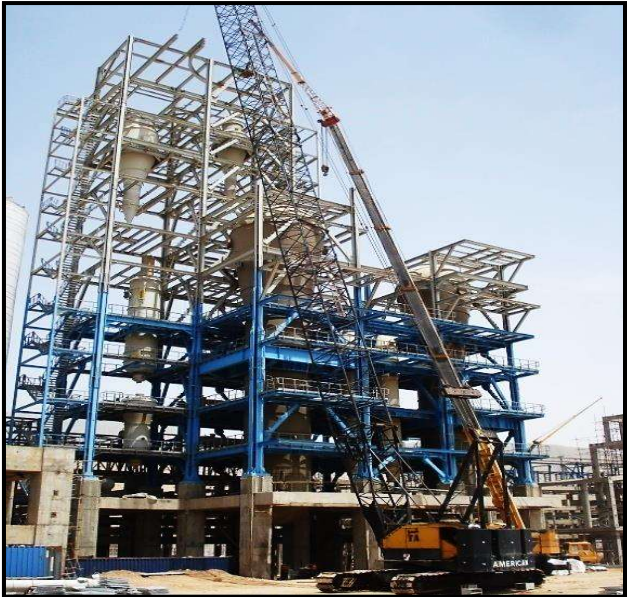
ساخت و نصب اسکلت فلزی واحد بوتن پتروشیمی لرستان
